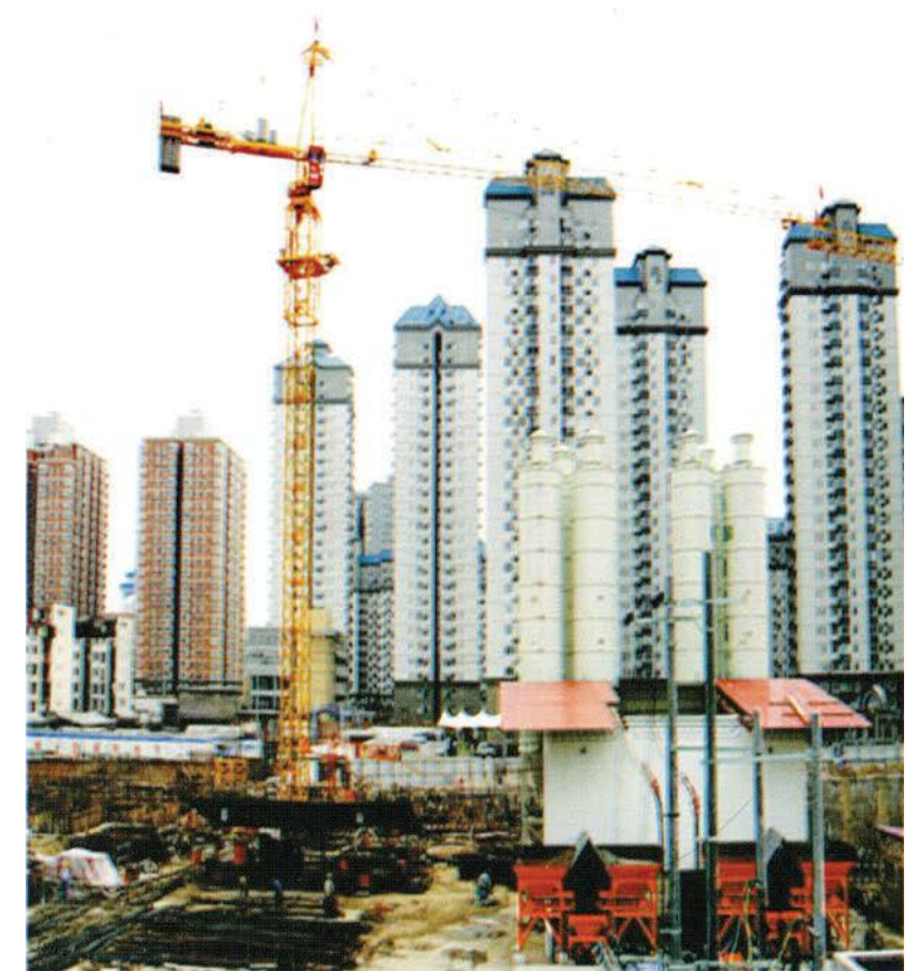
Thiết bị đang được sử dụng tại công trình
